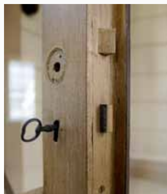
Original låskasse overhelt og så god som ny. Maler har malt over frontstolpe (teknikken heter ådring), en vanlig teknikk for la litt billig treverk , for eksempel å la gran og furu se ut som for eksempel eik.
