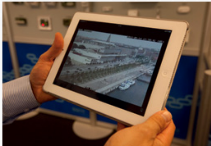
OVERVÅKER PÅ NETTBRETT: Ingebrigtsen viser frem nettbrettet som her benyttes som billedmonitor for kameraet som overvåker anløpsterminalen til Color Line i Kiel. Fra nettbrettet kan man også styre kameraet.
