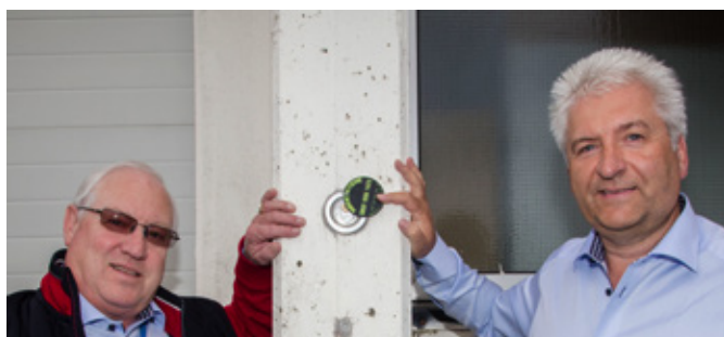
NØKKELSAFE I VEGGEN: Nøkkelsafen som er boret inn i betongveggen er markert med fluoriserende skrift. Den kan bare åpnes med kombinasjon av nødetatnøkkel og bruk av autorisert telefon, forteller Stein Erik Hansen og Geir Boge i Bergen Låsservice.
